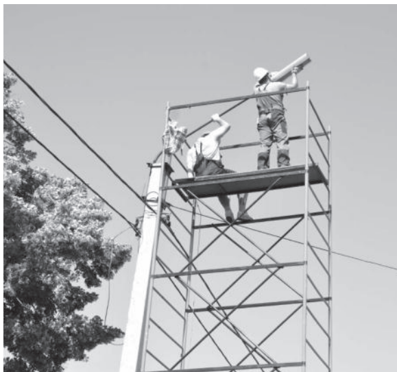
Замена ламп на светодиодные в системе уличного освещения станицы Егорлыкской
