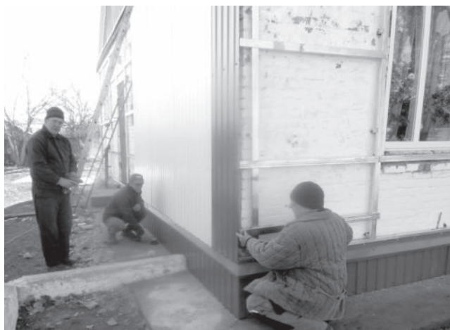
Идут работы по облицовке здания сельского клуба в х. Прогресс
