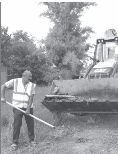
Завершается один из этапов ямочного ремонта по пер. Гагарина
